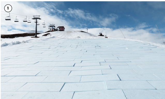
1 Aufschütten des Schnees in Trapezform. Optional: Abdecken der Krone (= Oberseite) mit Perimeterdämmplatten PSN
