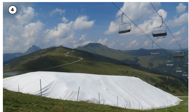
4 Überdecken des gesamten Schneedepots mit Gletschervliesbahnen + Fixieren des Vlieses mit Klettstreifen + Eingraben des Vliesendes am Boden zur besseren Fixierung. Ihr Schneedepot ist fertig.
