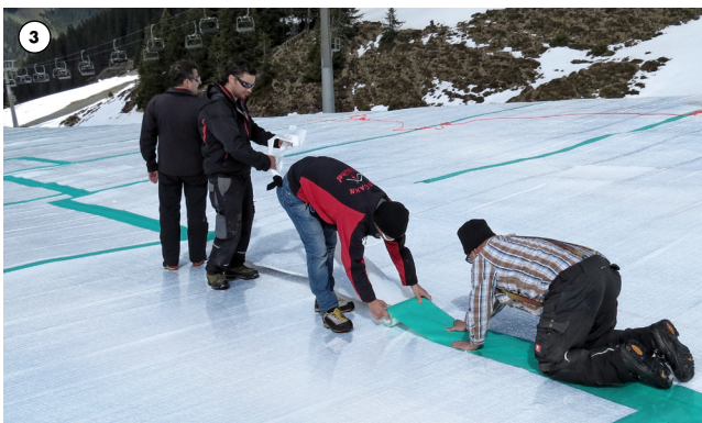
3 Zum Fixieren Schneedepot-Matten mit Nahtabdeckband zusammenkleben
