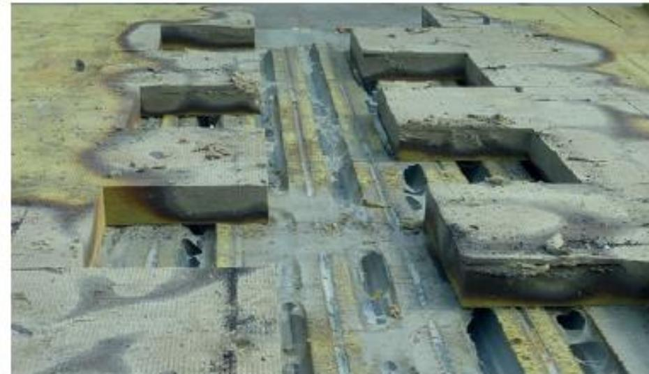
Bild 12 | MW-Dach – Dampfsperre teilweise geschmolzen
