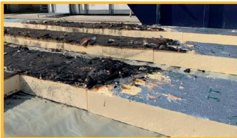
Bild 13 | Brandschädigung der verschiedenen Schichten des Dachaufbaus
