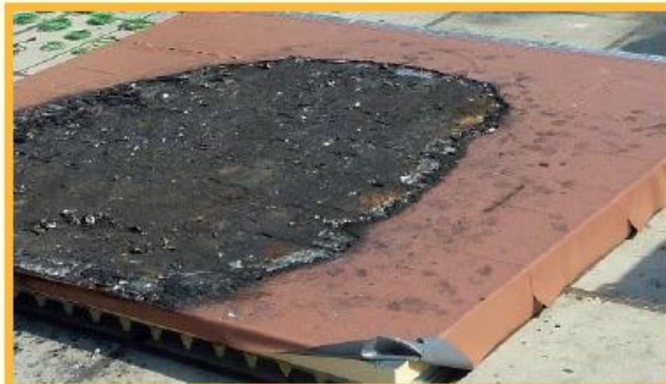
Bild 5 | PU-Dach – verbrannte Fläche nach Entfernen der PV-Elemente
