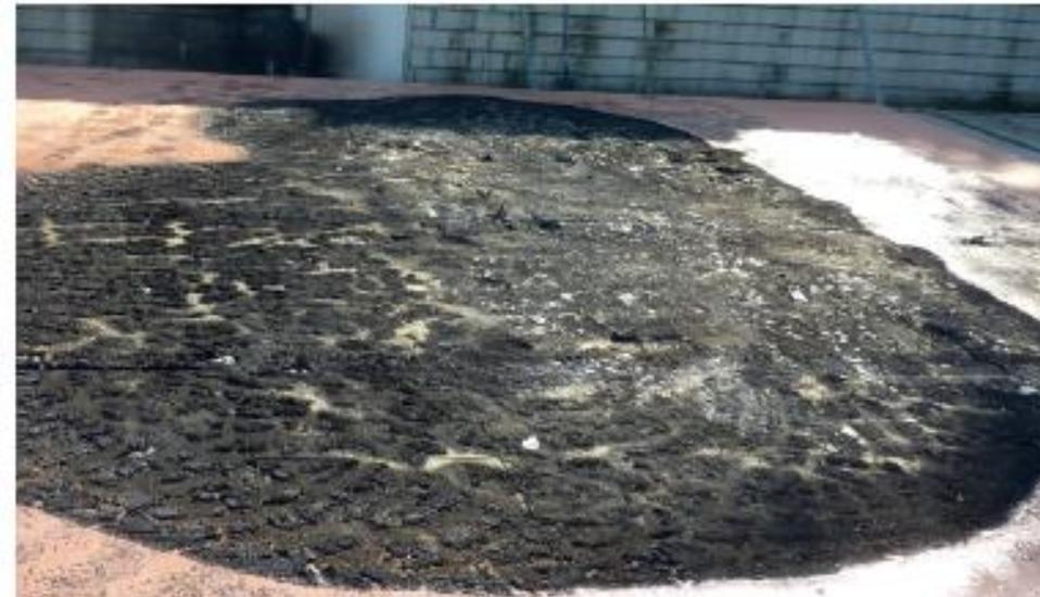
Bild 6 | MW-Dach – verbrannte Fläche nach Entfernen der PV-Elemente
