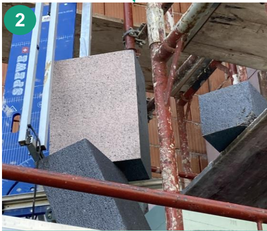
2 ~7% der EPS-Menge je Baustelle fallen als Abschnitte an
