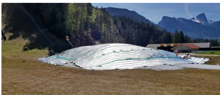
Ein Depot im Kleinformat. Grundsätzlich gilt: je größer, desto geringer die thermisch bedingten Verluste.
