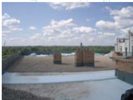
Izolacja dachu płaskiego
