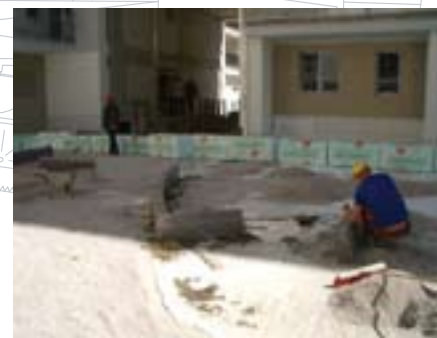
Izolacja drogi przeciwpożarowej
