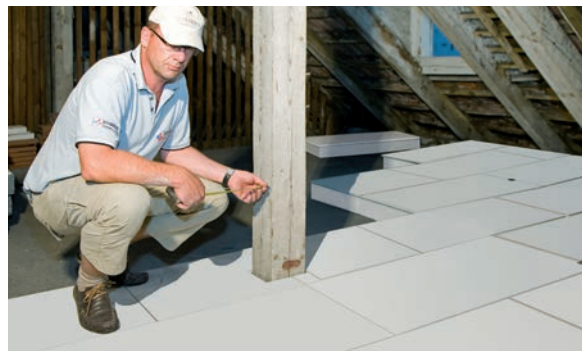
6) Elemente sind sofort nach der Verlegung begehbar
