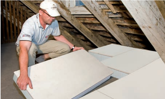
1) Elemente reihenweise im Verband verlegen
