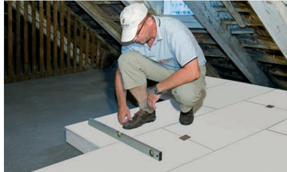
2) Boden auf Unebenheiten prüfen
