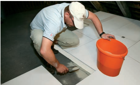
3) Unebenheiten gegebenenfalls mit trockenem Sand oder Feinkies ausgleichen
