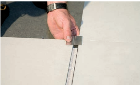
5) Elemente bei Bedarf mit DBE-Verbindungsprofilen fixieren
